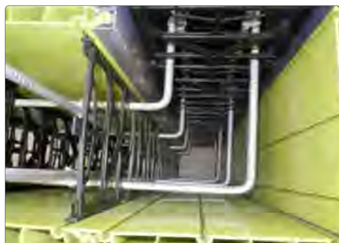
Particolare montaggio angolo.
